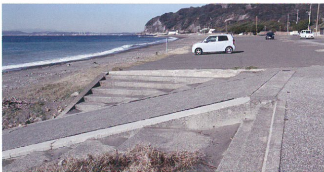
保田海岸第一駐車場とスロープ
