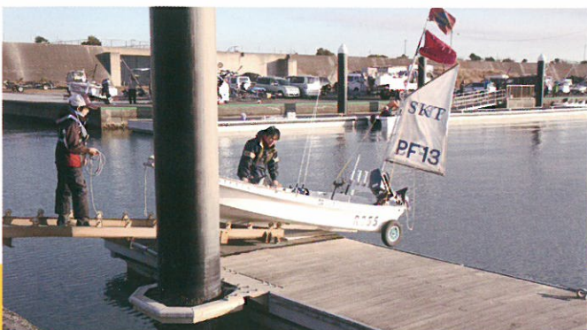
平塚漁港フィッシャリーナではこの「簡易スロープ」でボートを海に下ろす
